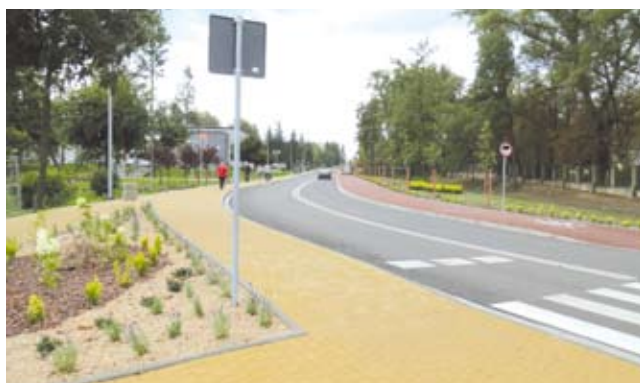
Zmodernizowana ul. Górnicza
