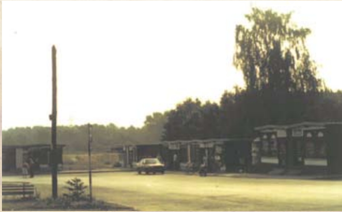
Zajezdnia autobusowa w 1991 r. Wówczas pojawiły się na niej pawilony handlowe - aktualnie rozebrane w związku z budową dworca. W tle brakuje - widocznych dzisiaj - zabudowań targowiska i marketów.
