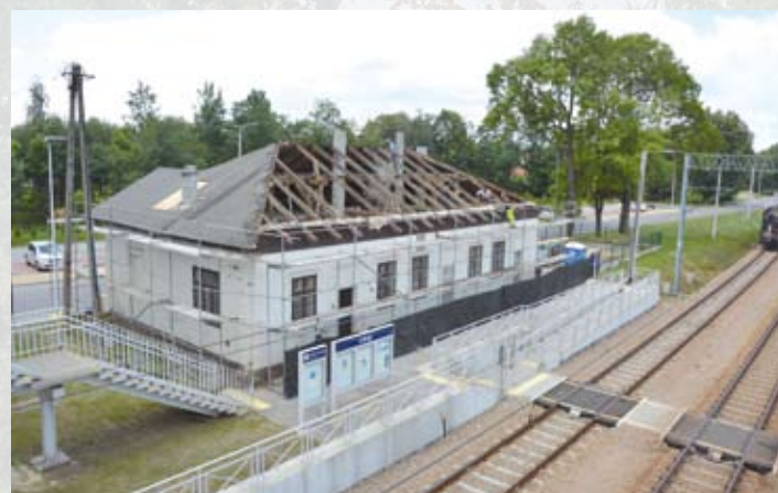
Rozpoczęły się prace budowlane przy domu dziennego pobytu dla osób starszych
