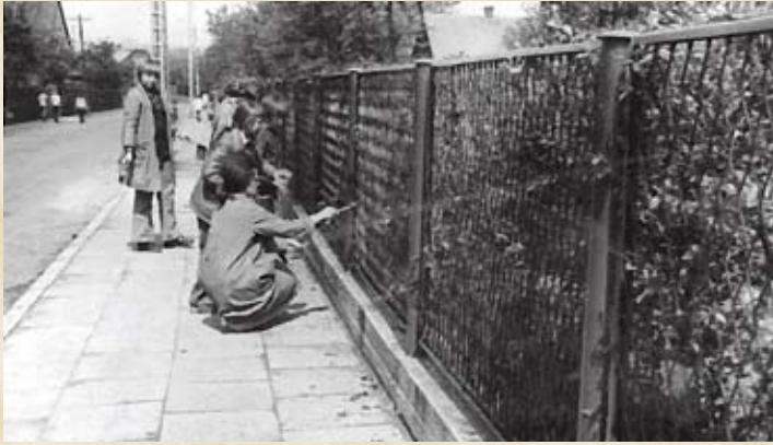
Malowanie ogrodzenia szkoły od strony ul. św. Barbary - przy pracy dyrektor Władysława Waliczek.
