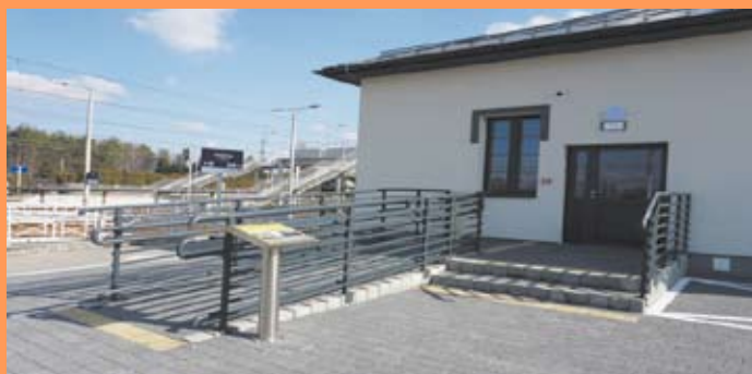
1.345.379,31 zł - adaptacja budynku nieczynnego dworca PKP na Dom Pobytu Dziennego
