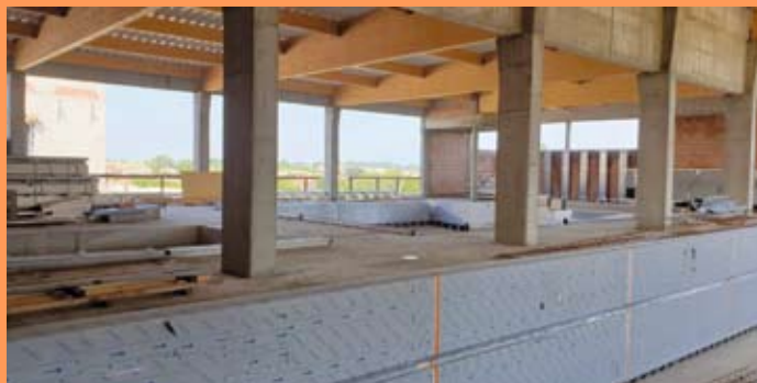
3.337.077,90 zł. – rozpoczęcie budowy krytej pływalni
