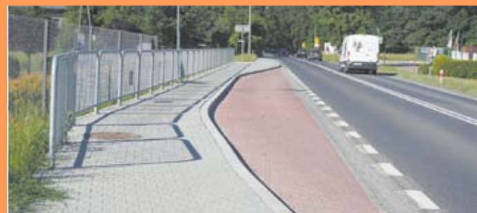
761 865,06 zł – budowa chodnika przy ul. Beskidzkiej w Libiążu (w tym dotacja z województwa 400.000 zł.)
