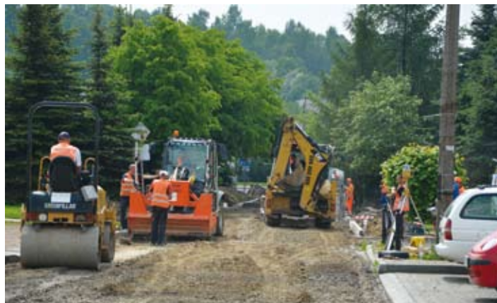
Ulica Paderewskiego podczas prac
