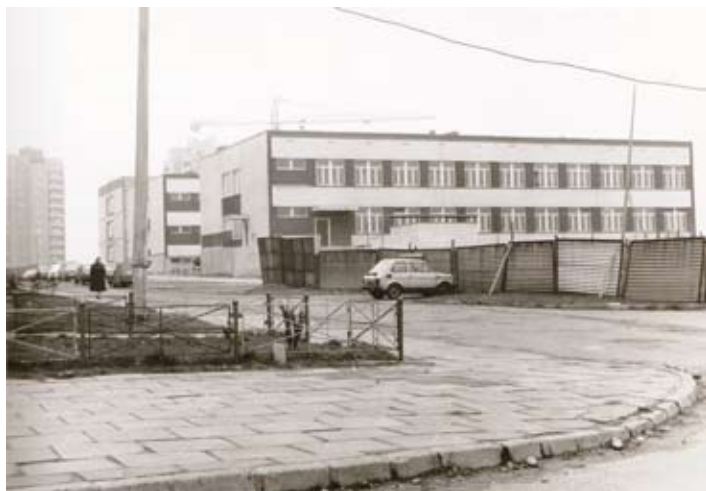
Szkoła Podstawowa nr 4 w budowie /fot. S. Patałuch/
