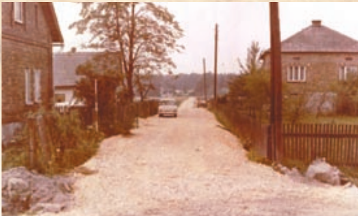
Ul. Świerkowa w Budzowach w 1979 r. utwardzana tłucznem dolomitowym. Wykorzystywanie tłucznia do budowy dróg w naturalny sposób wynikało z faktu funkcjonowania na terenie Libiąża kamieniołomu pozyskującego ten surowiec.
