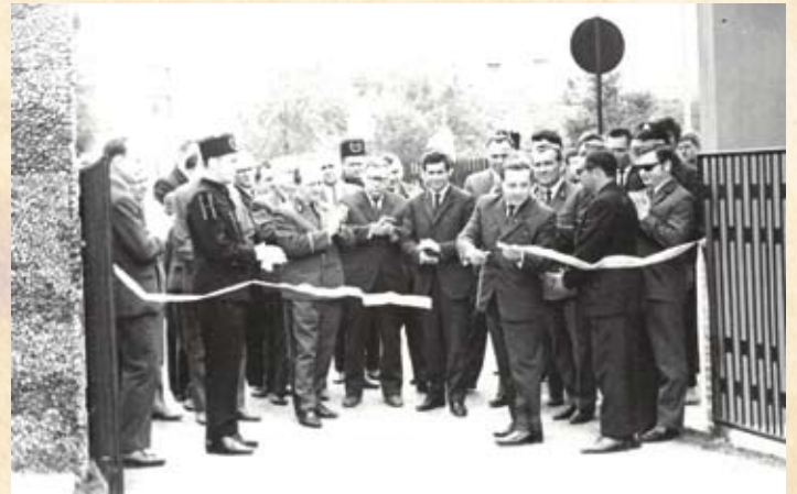
Otwarcie ośrodka rekreacyjno - wypoczynkowego na Pniakach. Budowę kierował społeczny komitet powołany przez FJN w 1967 r. Obiekt oddano do użytku w maju 1970 r. Składał się z boiska piłkarskiego, trybuny krytej, 50 metrowego basenu kąpielowego, brodzika dla dzieci, kawiarni i terenów zielonych.
