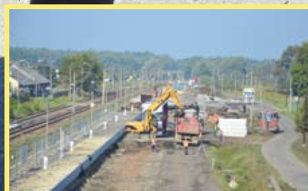
REMONT DWORCA PKP
