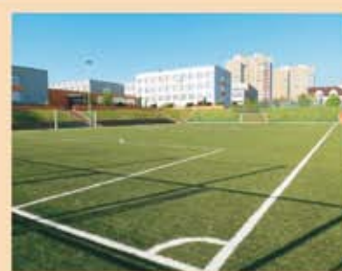
Budowa boiska typu Orlik - Zakończenie programu "Budowy boisk przy każdej szkole"
