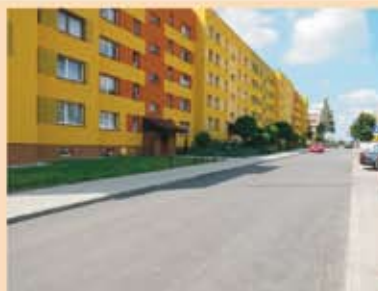
Modernizacja gminnych dróg (ul. Paderewskiego, Ks. Flasińskiego Kochanowskiego, Mickiewicza)
