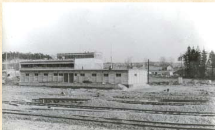
Budowa bocznicy kolejowej.
