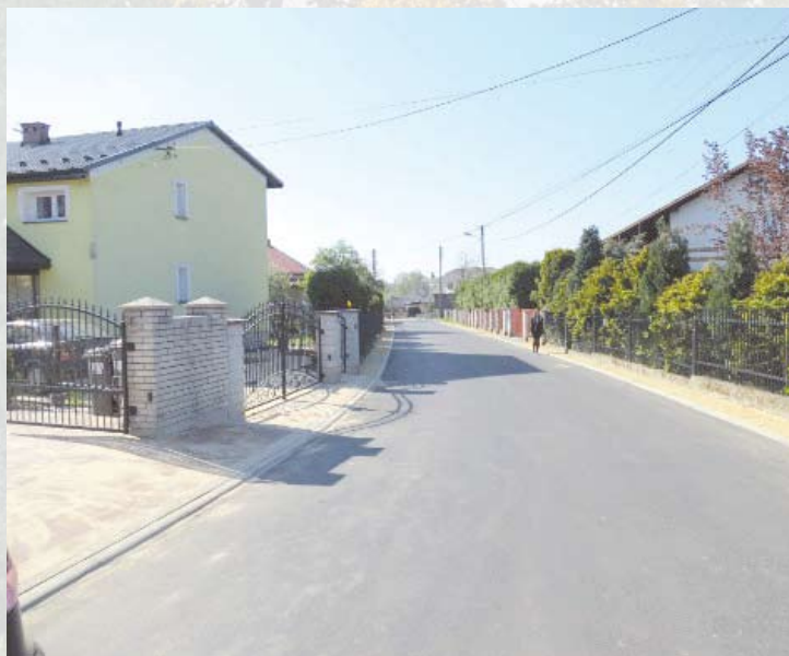
Ulica Piastów w Żarkach po przebudowie
