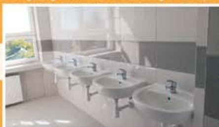
Zmodernizowane sanitariaty w Zespole Szkół w Żarkach
