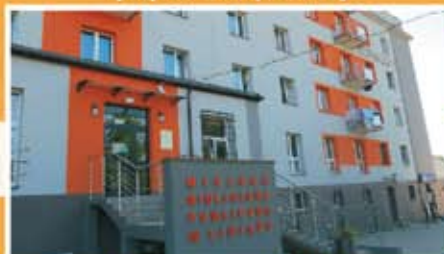
Termomodernizacja Miejskiej Biblioteki Publicznej w Libiążu
