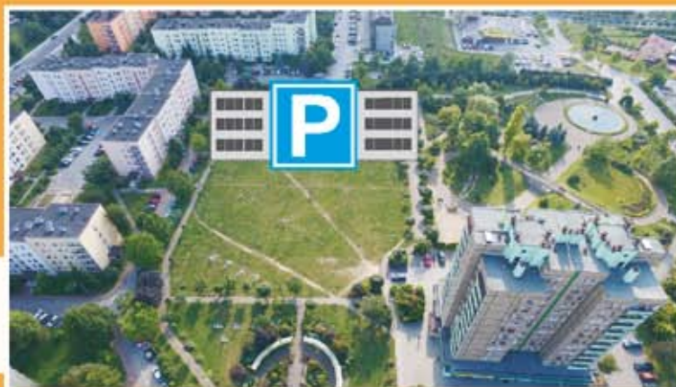
Budowa parkingu na os. Flagówka w Libiążu
