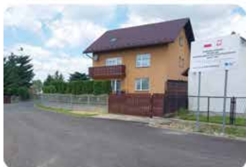
UL. PRZASNYKA W ŻARKACH
