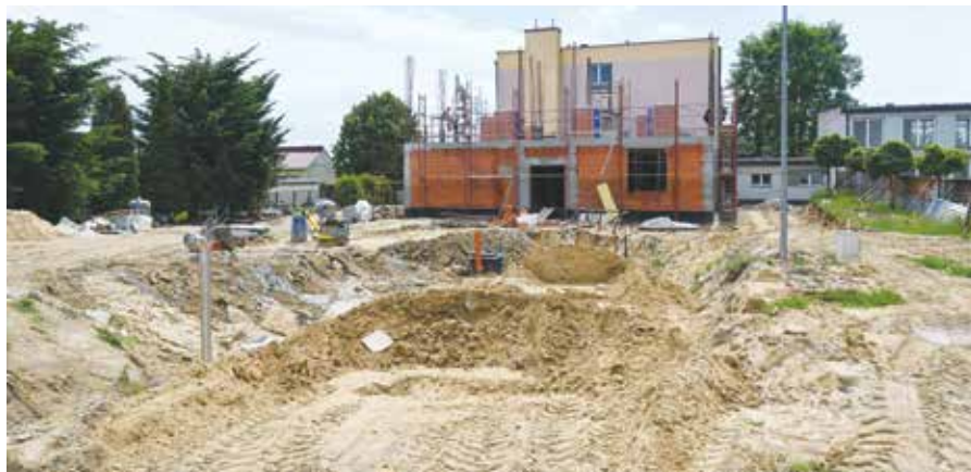
Na placu budowy przedszkola w Żarkach
